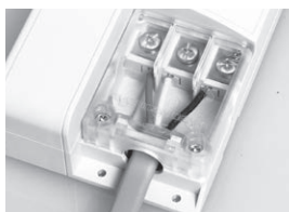
引締式接続例 (VVF1.6mm)
